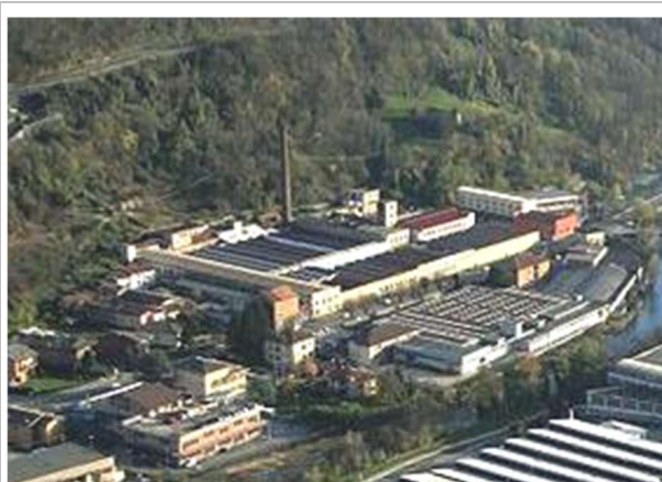
Fotografia 5: Insediamento industriale in località Serio.
